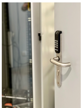
Een Aperio beslag met keypad voor 2-weg verificatie met pincode.
